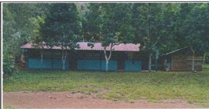
Foto 5: Cambio de pintura de pared.
