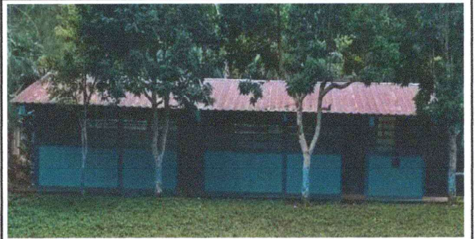
Foto 4: Colocacion de malla.
